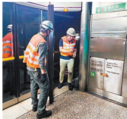
◆港鐵工程人員進入隧道搶修。
