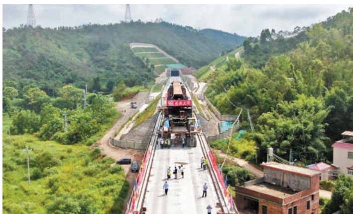
◆梅龍高鐵施工現場。
