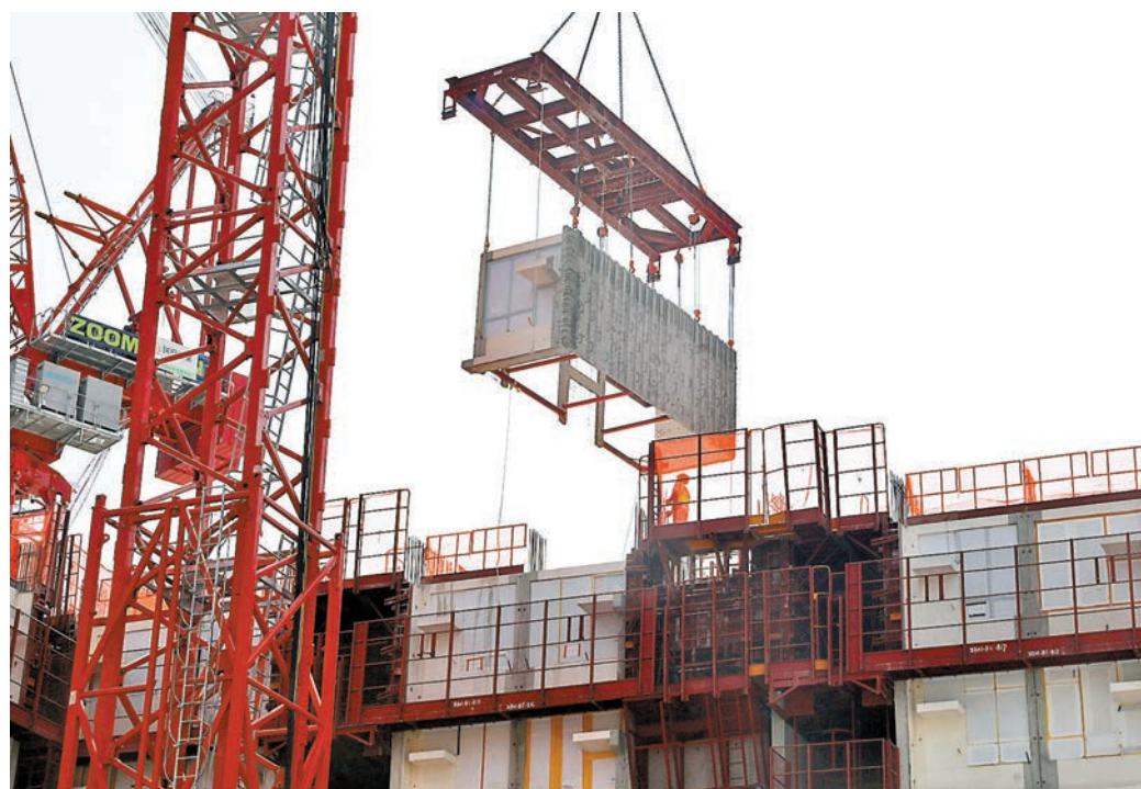
開發第二代(MiC 2.0)，以完善組裝合成建築法的可建造性、安全性、結構效率和建造速度。
