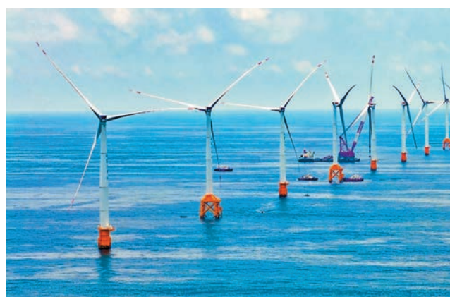
◆中廣核惠州港口100萬千瓦海上風電場。
