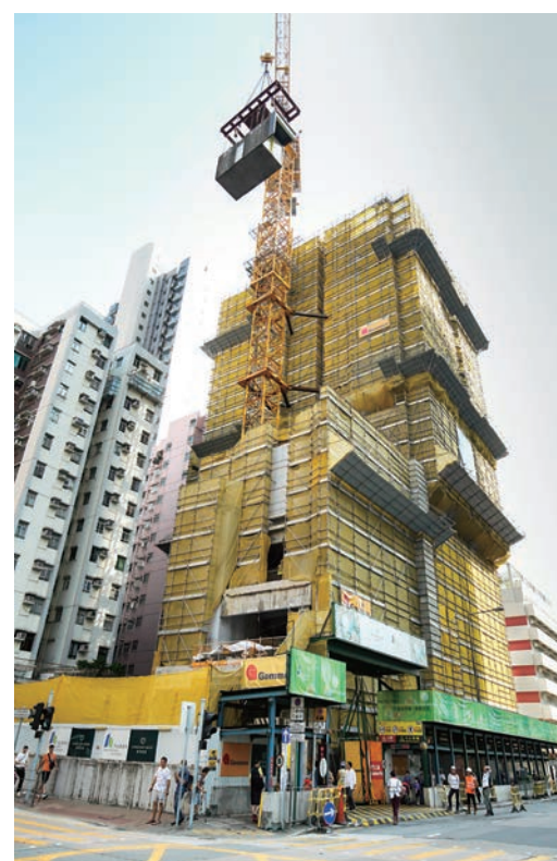
▲華懋與市建局合作之東京街重建項目，為本港首個引入「組裝合成」建築法的私人發展項目，有助縮短建築期，並減少建築期間對周邊社區影響。
