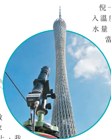
▲高速攝像機測量廣州塔塔頂位移。
