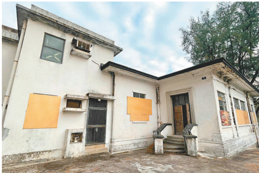
屯門前哥頓軍營 Watervale House，被發展局納入第七期「活化歷史建築夥伴計劃」。圖為建築入口處。
