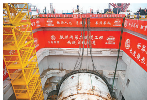
◆12月30日，青島膠州灣第二隧道主線隧道開始盾構掘進，標誌着我國建設規模最大、長度最長的海底道路隧道主體正式開啟盾構穿海作業。新華社
