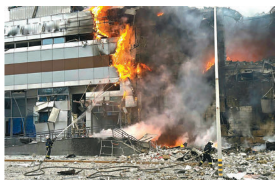
◆基輔建築物嚴重受損，消防員到場救火。美聯社
