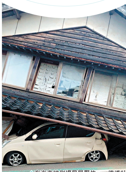
◆有汽車被倒塌房屋壓住。路透社
