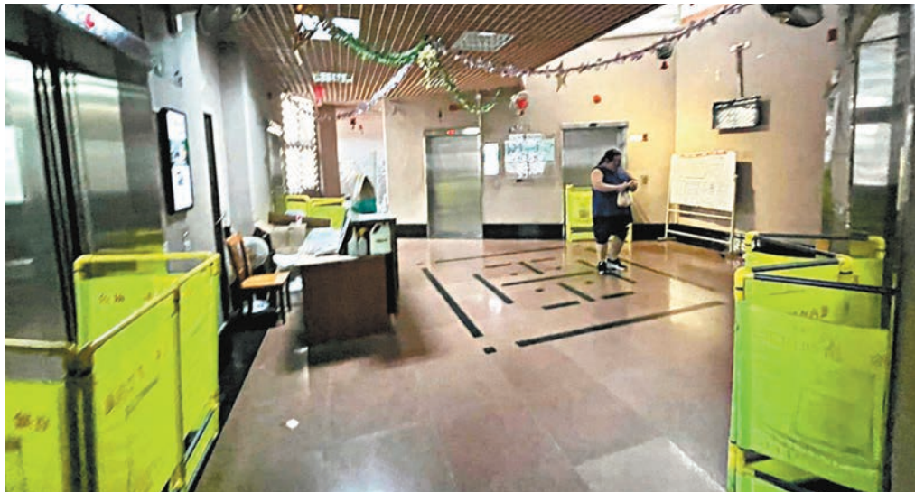
▶變電站事故導致停電，有大廈將升降機圍封停用。 網上圖片
