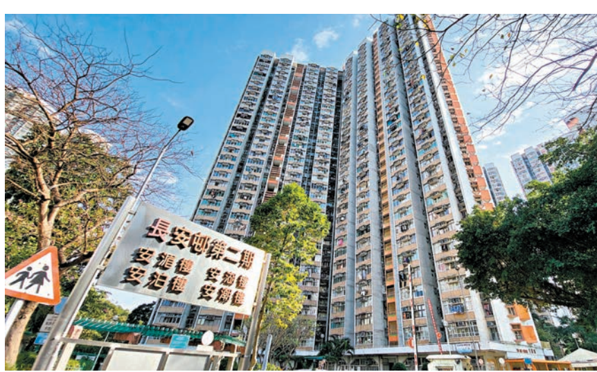
◆前日長安邨安瀾樓變電站事故中，有388戶受影響停電近90分鐘。 資料圖片
