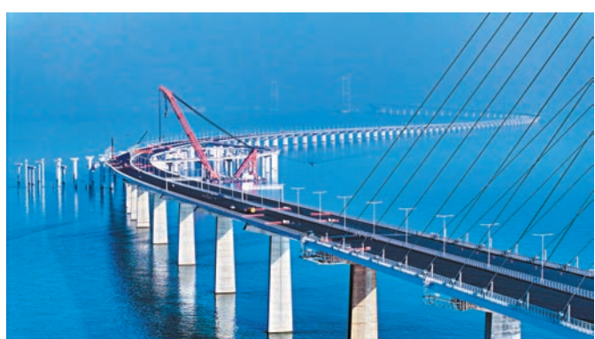
◆深中通道將於今年建成通車。圖為通道建設中。香港文匯報中山傳真
