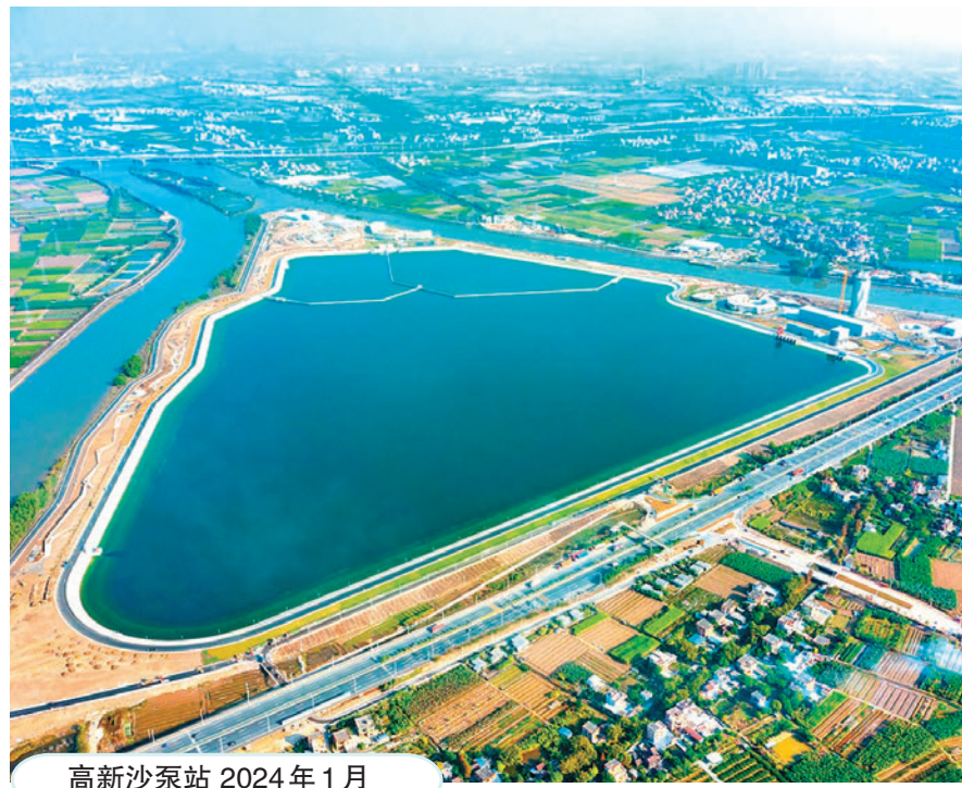
高新沙泵站 2024年1月
