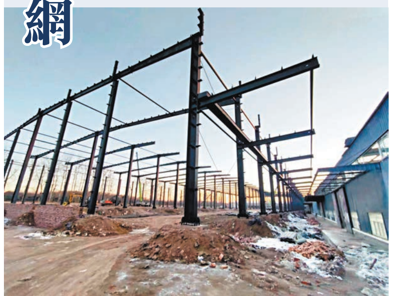
正在改建的西南物流庫房，未來將建成智能化圖書倉儲空間。
