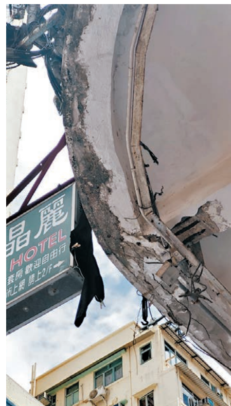
◆近年香港接連發生多宗舊樓石屎剝落事件，引發大眾對樓宇老化問題的關注。 資料圖片
