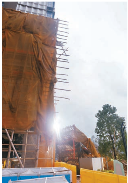
▲塌下的大幅棚架壓在地盤路中。網上圖片
