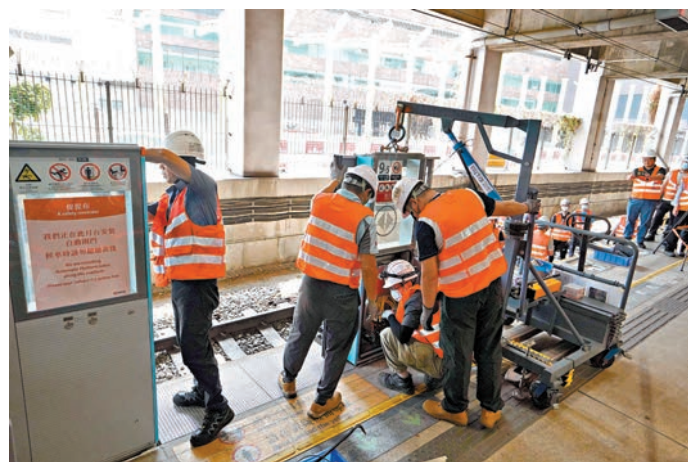
◆港鐵預料今年底共有9個車站完成安裝自動幕門，可望於明年內完成全線車站月台的近1,600對自動幕門安裝。
