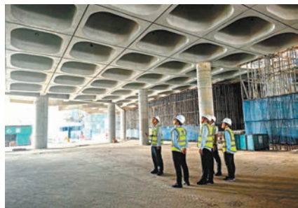
◆中建科工深圳灣文化廣場項目施工現場，工作人員正在進行安全檢查。香港文匯報記者郭若溪攝
