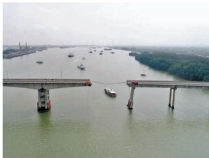
◆2月22日5時30分左右，一艘集裝箱船航經洪奇瀝水道時觸碰瀝心沙大橋橋墩，致瀝心沙大橋橋面斷裂。新華社
