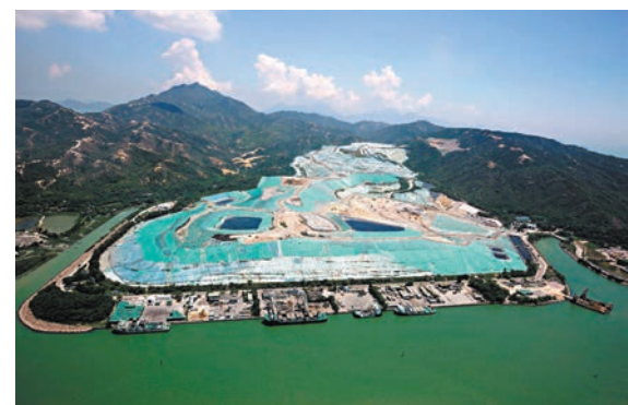
◆新界西堆填區擴建地盤有男工昏迷近7小時始被發現,送院死亡。圖為肇事地盤。環保署網站圖片
