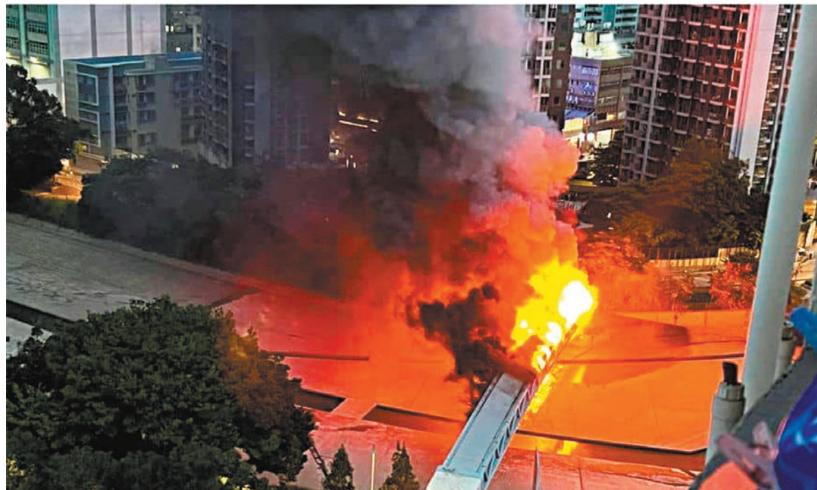
◆2022年6月，元朗宏樂街中電電纜橋起火事故，導致17.6萬戶停電持續1,100分鐘，同年中電共發生2,987宗停電事故，但該年仍獲1,940萬元「恢復供電」獎賞。圖為電纜橋起火一刻。資料圖片
