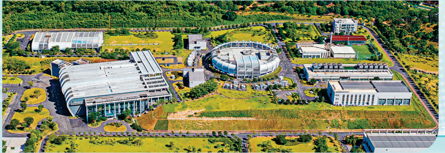
◆中國散裂中子源裝置航拍圖。
