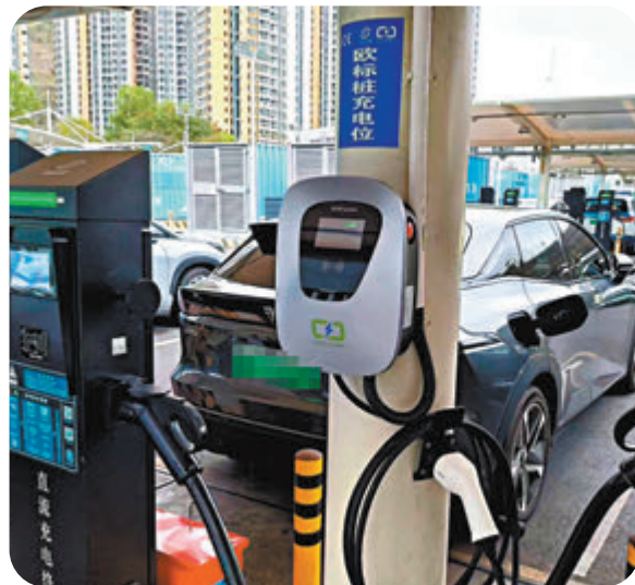
深圳深康村停車場內的「歐標」充電樁。香港文匯報記者郭若溪攝
