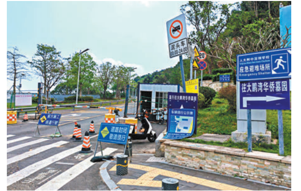
◆鹽葵路小梅沙至華僑墓園段正在改造施工，道路封閉。香港文匯報記者石華 攝
