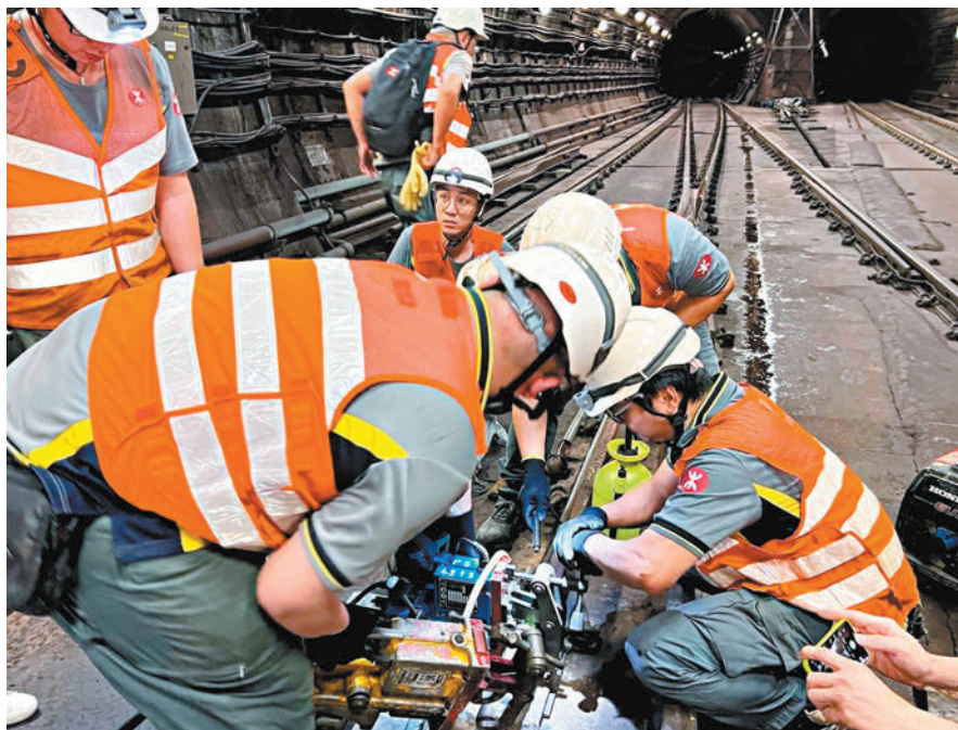
港鐵工程人員正為出現裂縫的路軌進行臨時加固。受港鐵荃灣線尖沙咀站附近路軌發現裂縫影響，列車全日有延遲，須額外多3分鐘至5分鐘。
