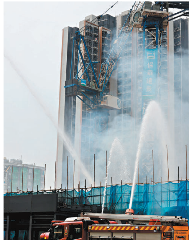
◆消防員昨日繼續在天水圍洪雅路發生四級火地盤外圍射水灌救。
