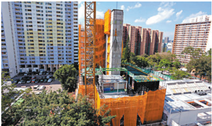
◆房協於沙田乙明邨以「組裝合成」建築法興建的長者住屋項目。
