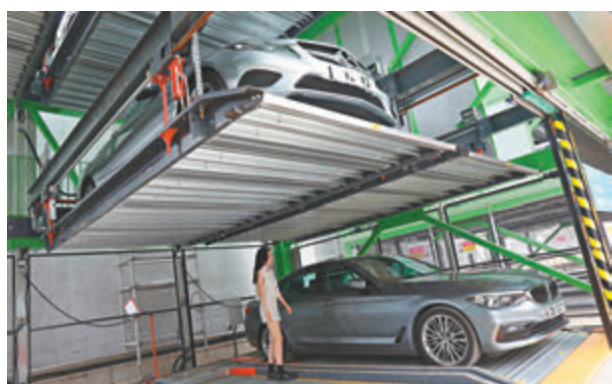
◆深水埗欽州街和通州街交界的全港第三個自動泊車系統停車場竣工。香港文匯報記者萬霜攝
