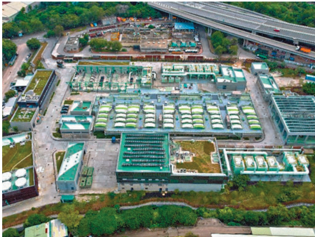
◆元朗新圍污水處理廠持續出現滲漏及積水問題。
