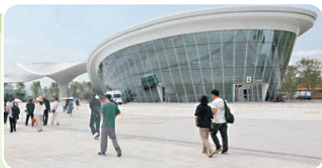
◆綜合服務館入口。
