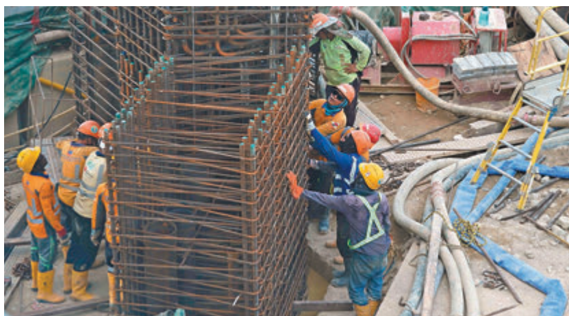
◆《建造業付款保障條例草案》於本月29日提交立法會首讀及二讀，發展局希望年內通過，以加強保障工人生計。圖為工作中的地盤工人。 資料圖片
