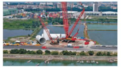
◆全球單機容量最大「海上風電機組」在廣東汕頭臨海試驗基地進行塔筒吊裝。
