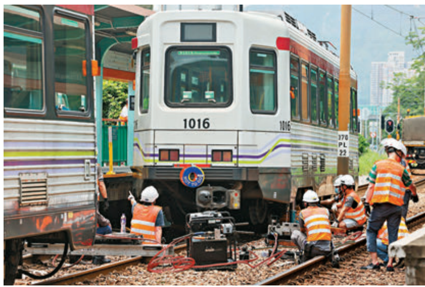
◆出軌輕鐵列車駛過的路軌出現損毀，行人過路處有石屎板損毀碎成多塊。香港文匯報記者鄭福強攝
