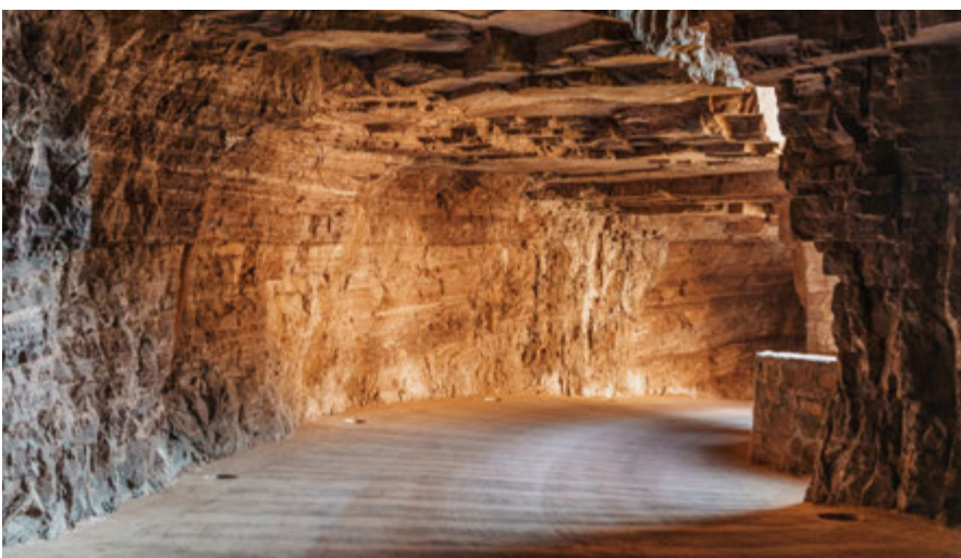
◆ 郭亮洞掛壁公路被譽為「太行隧道之父」，它讓藏在深山的自然奇景展露於世。
