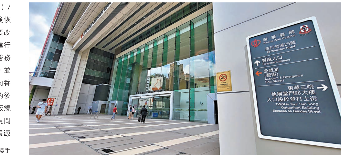
◆廣華醫院電力系統於6月19日晚上約7時發生故障，影響部分手術室的電力供應。圖為廣華醫院入口。 香港文匯報記者鄧偉明 攝
