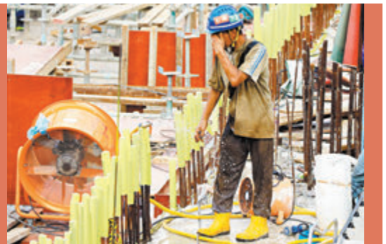
▲地盤設有風機和流動涼亭，工人適時灑水降溫。香港文匯報記者北山彥攝
