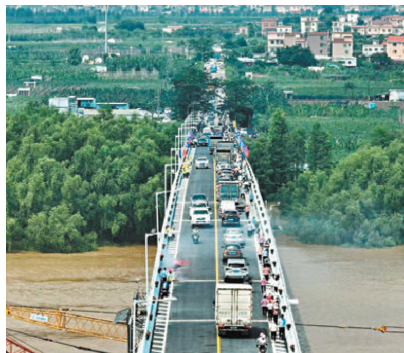
◆ 三民島民眾已可通過大橋進出島。 香港文匯報廣州傳真
