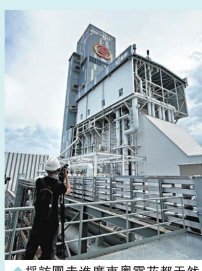
◆採訪團走進廣東粵電花都天然氣熱電有限公司採訪。
