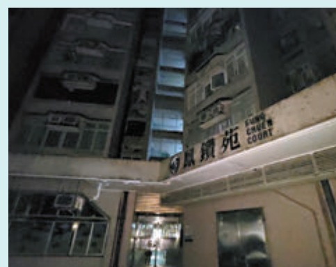
◆受中電電壓驟降影響，鑽石山鳳鑽苑本月23日凌晨停電逾兩小時。
