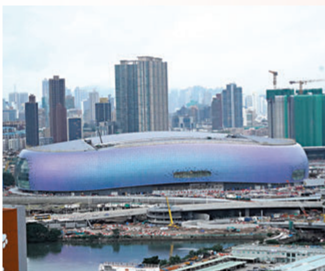
◆上月中旬拍攝的啟德體育園最大的場館大致今年年底完成工程。 資料圖片
