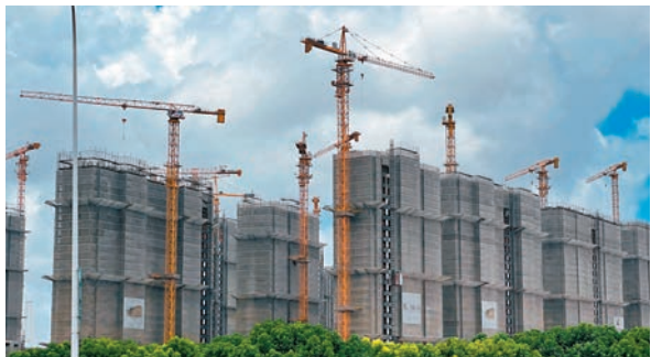
◆圖為上海一處在建樓盤。資料圖片 內地多家機構監測數據顯示，在「517」樓市新政策之下，北上廣深等一線城市的樓市正呈現復甦態勢，其中二手房市場「以價換量」，交易活躍度
