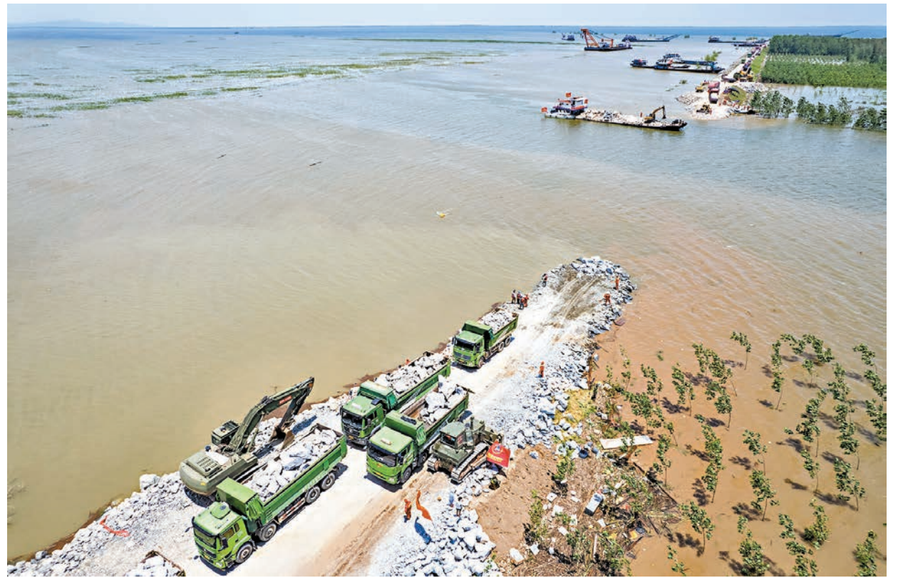
▲7月7日，在現場可以看到，滿載塊石、砂卵石等物料的卡車緊張投放，大型駁船同步開展水上拋投作業，增加水上拋投之後，堵口進度進一步加快。 新華社
