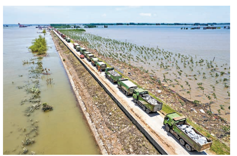
◆7月7日，在湖南省岳陽市華容縣團洲垸洞庭湖大堤決口現場，搶險車隊排隊進行堵口作業。 新華社
