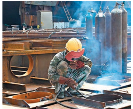
◆ 早前在海南某造船廠，一名技術工人對船體基礎框架組件進行焊接。
