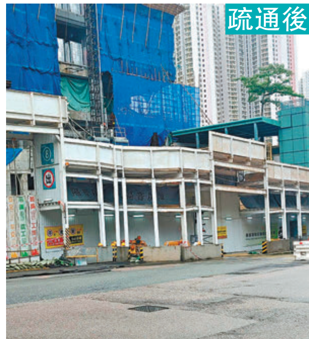
◆渠務署緊急應變隊伍接報後一至兩小時內，完成處理及清除水浸。
