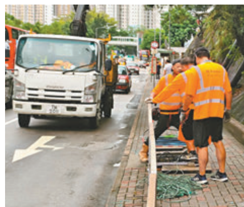
◆渠務署工人在秀茂坪道疏通渠道。
