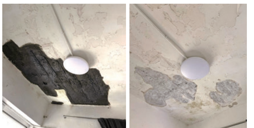
◆丁天佑的工程隊伍將對指定單位(房間及廚房)的剝落石屎區域進行前期整理：敲鬆鬆散石屎以穩固基底，剝除鋼筋漆油便於處理，鋼絲刷除鏽保持鋼筋乾淨，最後塗抹防鏽油以防鏽蝕。此工作為後續施工奠定堅實基礎。
