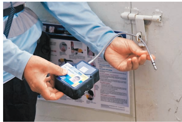
▲危險區域進出管制（電子鎖系統），以電子鎖和鑰匙系統管制危險區。 香港文匯報記者涂穴 攝
