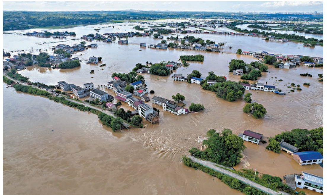
自28日起，短短24小時之內，流經湘潭縣的涓水，自上游至下游，陸續出現三處決口。這是7月29日拍攝的涓水湘潭縣河口鎮華中村堤段決口險情現場（無人機照片）。新華社
