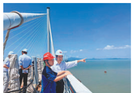
◆陳浩濂到訪港珠澳大橋西向延伸項目——連接廣東台山和珠海的茅茅海跨海通道。
