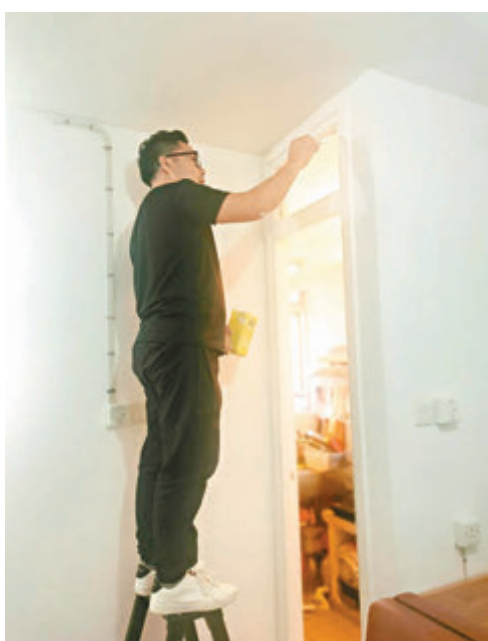
◆元朗區悅恩關愛隊幫助市民修補天花。受訪者供圖
